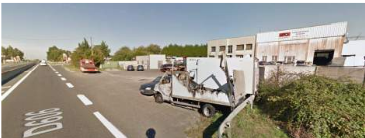
Figure 5 Vue 3 – Depuis le D606 en direction de l'est vers la casse auto
