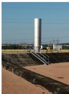
On observe la torchère de sécurité qui est une torchère à flamme non apparente. Elle est utilisée en cas de défaillance de l'injection du gaz dans le réseau. Le torchage du gaz est évité autant que possible car les revenus de l'installation dépendent de la bonne valorisation du gaz. La plupart du temps la torchère ne fonctionne donc pas.
