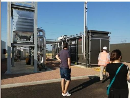
Avant d'être injecté sur le réseau (ici GRDF), le biogaz produit par la méthanisation doit être épuré pour atteindre la composition en méthane (CH<sub>4</sub>) requise par le réseau national. Ce procédé inclut 2 étapes :
